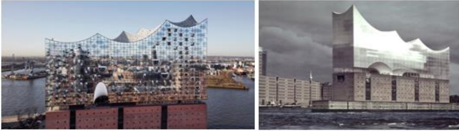
Fig.9. Filcharmony in Hamburg. Architects: Herzog & de Meuron.
