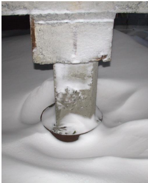
Fig. 1. Boring pile (case of Norilsk).
