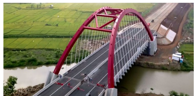
Fig. 1. Actual view of Kalikuto Bridge (Semarang – Batang)
