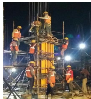
(b) Concrete pour (column)
