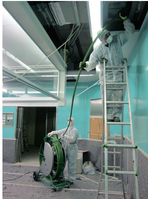
Fig.10: Illustrative picture of professional activity of air ducts inspection and cleaning from the publication “Impianti di climatizzazione: salute e sicurezza nelle attività di ispezione e bonifica” edited by Inail
