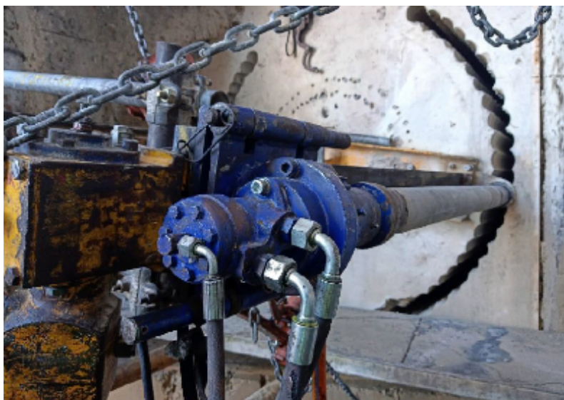
Fig. 8. Photographie Carottage Séquent. Source : photo Hydrokarst.
