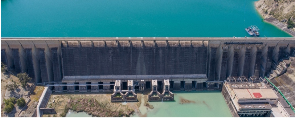
Fig. 1. Photographie du barrage Idriss 1 er . Source : Photo Hydrokarst.
