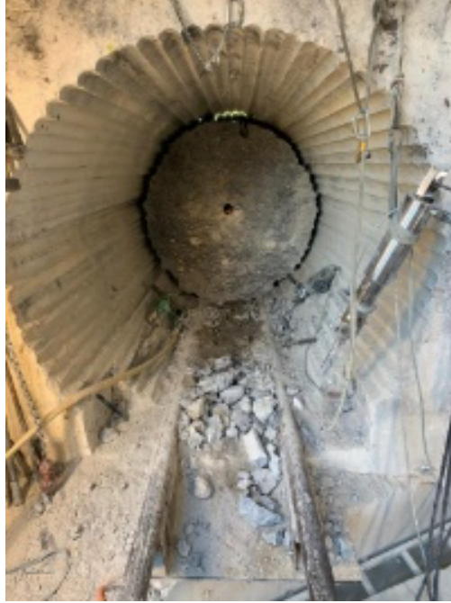
Fig. 9. Photographie Démolition de la Carotte. Source : photo Hydrokarst.
