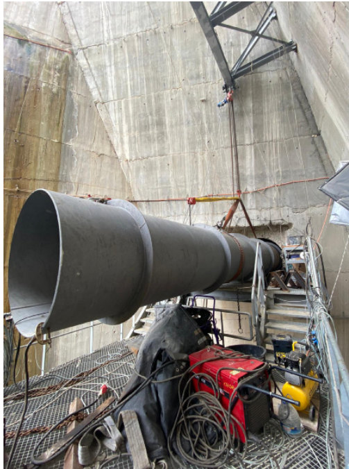
Fig. 12. Photographie insertion de la virole. Source : photo Hydrokarst.
