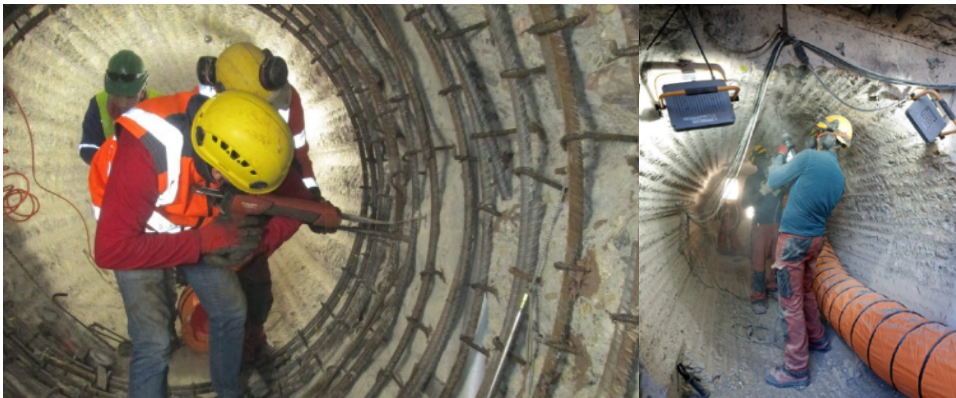
Fig. 10 et 11. Photographie Préparation des Surfaces. Source : photo Hydrokarst.
