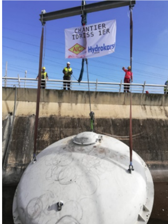
Fig. 7. Photographie Batardeage Amont. Source : photo Hydrokarst.
