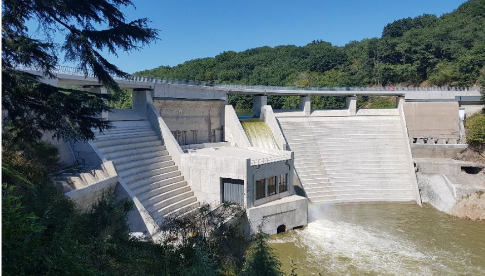
Fig. 8. Vue du barrage après travaux de modernisation.
