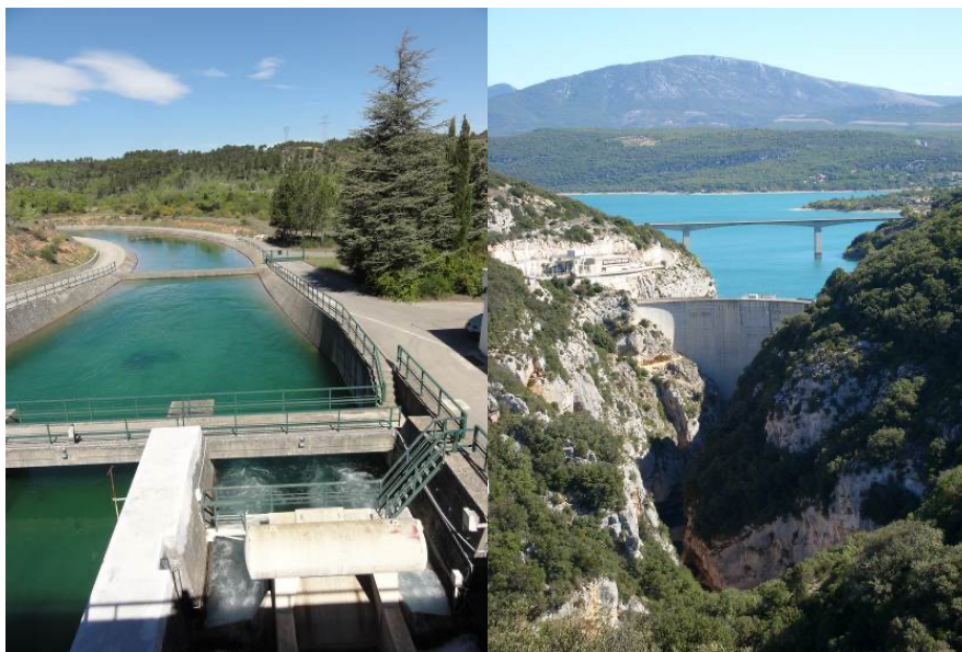
Fig. 3. Prise d'eau de la SCP à Boutre. Fig. 4. Barrage de Sainte-Croix.
