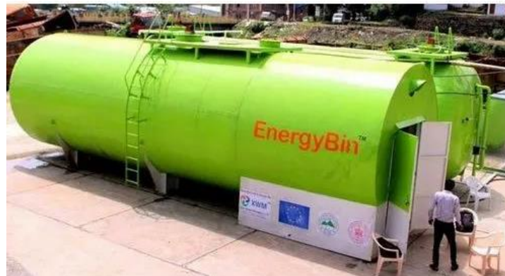
Fig. 6. Horizontal Digester
